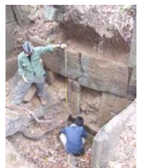
貯水池から下流へ用水を流す「ソロウワ(暗渠式水路)」。高度な土木技術が使われている。
